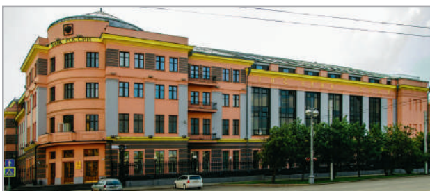
Капитальный ремонт Сибирского отделения Цент- рального банка России г. Иркутск
