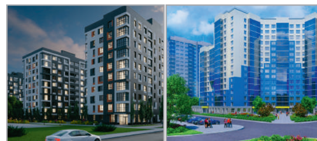
ЖК "Пальмира" г. Батайск ЖК "Лазурный" г. Новочебоксарск
